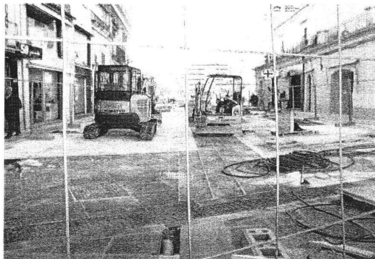
La pavimentazione del tratto tra via Salvatore e il ponte Pennavaria
